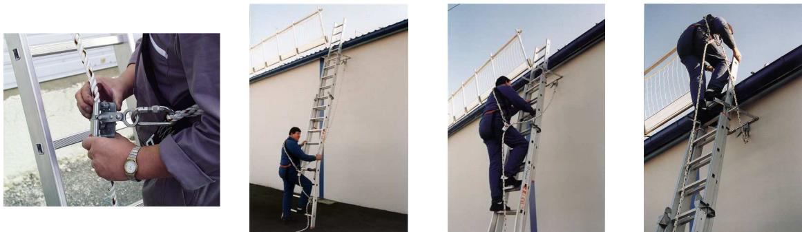
**NOTA BENE:** prima di sganciarsi dal DPI utilizzato lungo la scala è necessario assicurarsi ad un altro sistema anticaduta (punti di ancoraggio o fune anticaduta). A tale scopo è necessario utilizzare doppio cordino o sistema equivalente.
